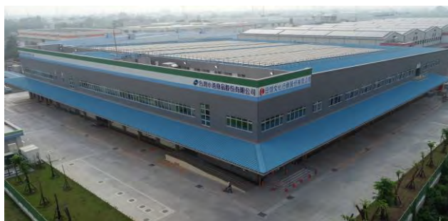
岡山多溫層物流中心
